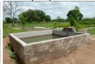
De nieuwe waterputten
